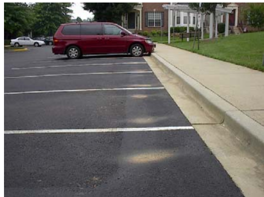
Sunken Asphalt
